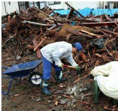
全壊し、瓦礫と化した住居の撤去作業
